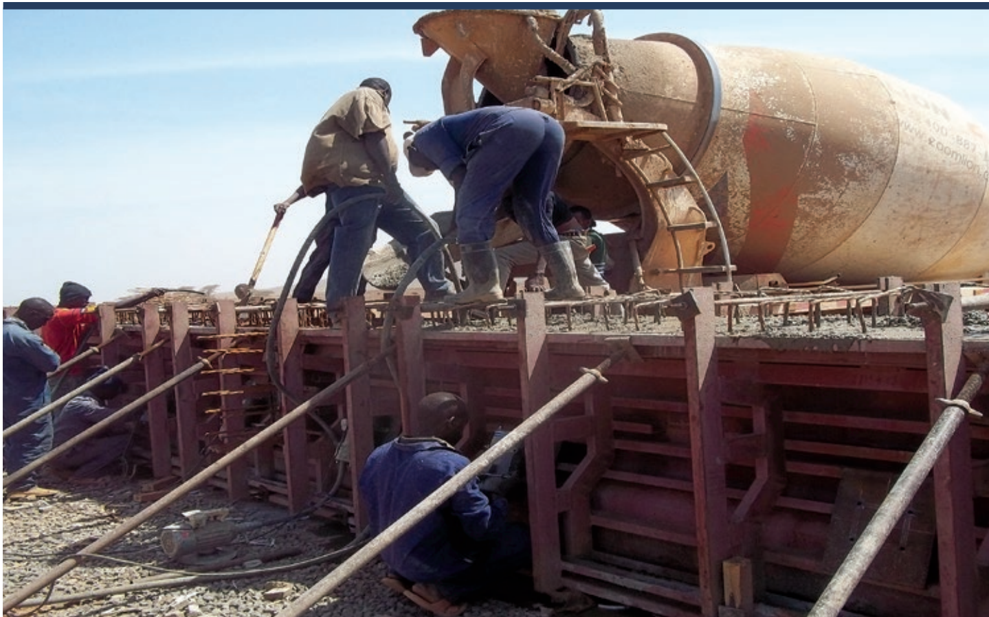
Des ouvriers près de Turbi au Kenya travaillent sur le chantier de l'autoroute devant relier le Kenya à l'Éthiopie. © Wanjohi Kabukuru
